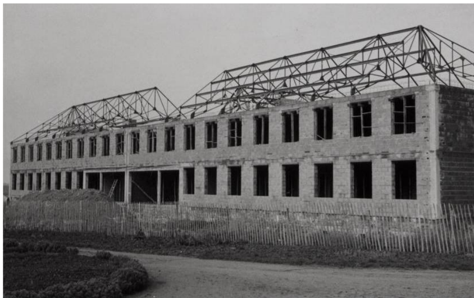
Construction de l'Unité de soins (coté sud)
