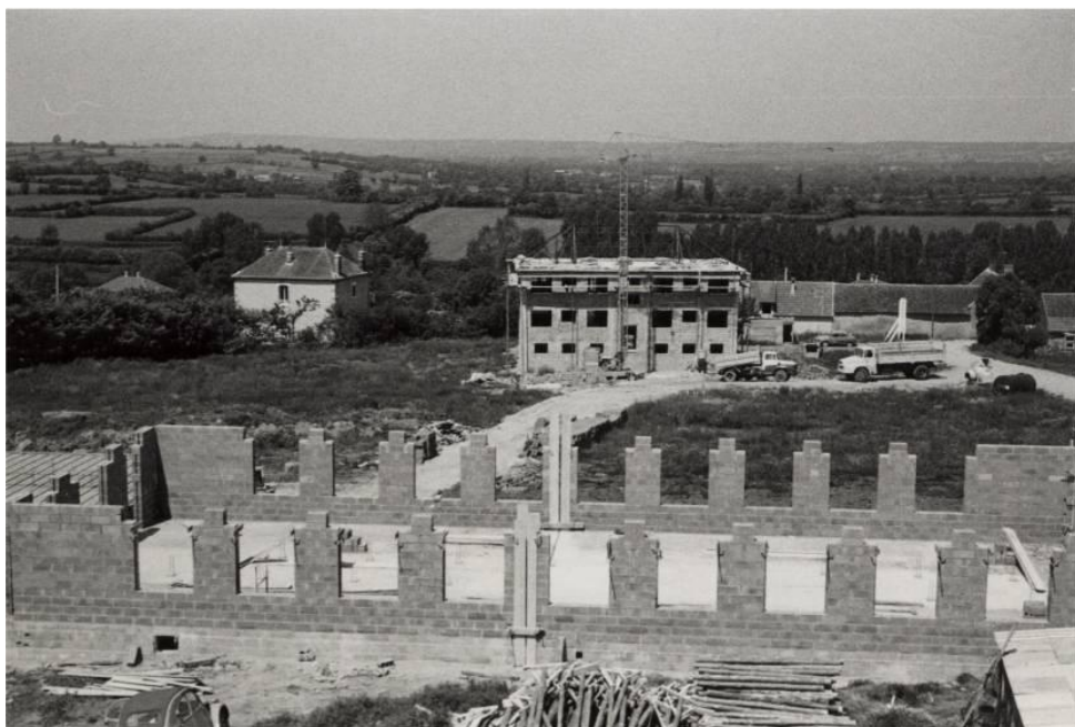
Construction du 1 er atelier d'ergothérapie et des logements des internes
