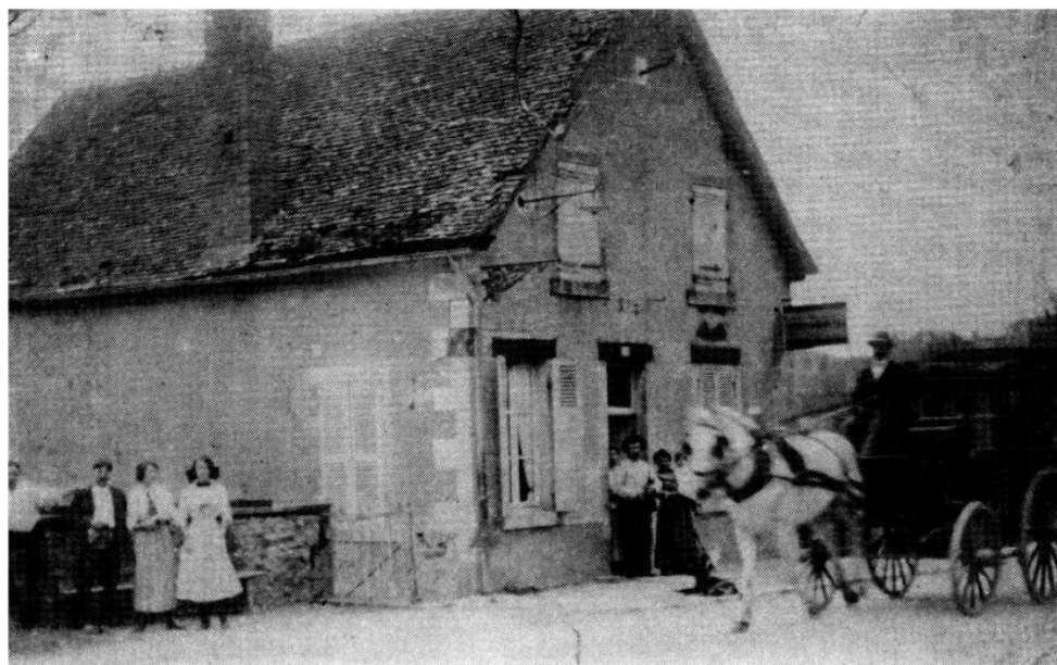
Ce bâtiment, près du pont sur la Sologne, abritait les bains de la Colonie
